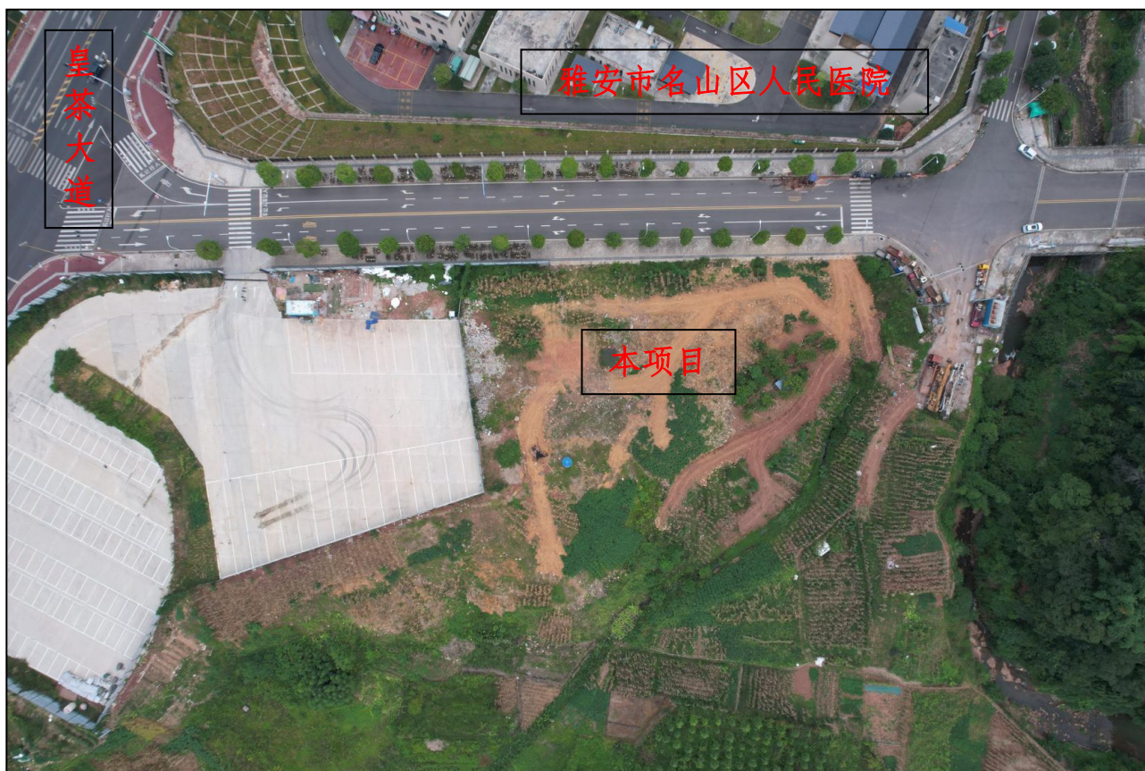
项目建设场地现状 1
